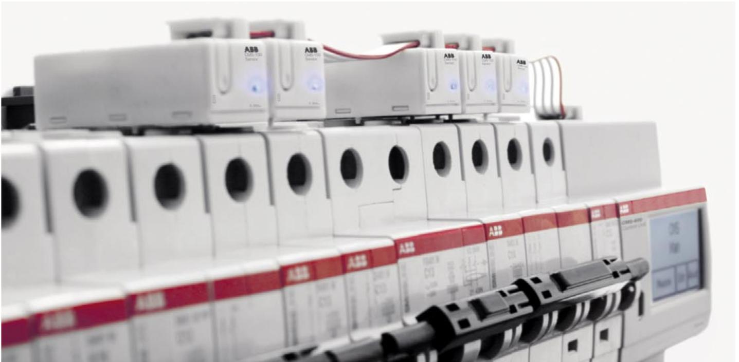
Auch die **Initialisierung der Sensoren** ist spielend einfach. Über die Control Unit werden den einzelnen Sensoren die gewünschten Kennungen mit wenigen Klicks zugewiesen. Die komplette Inbetriebnahme nimmt nur wenige Minuten in Anspruch. Direkt nach der Initialisierung stehen Ihnen alle Messfunktionen zur Verfügung und können am Display der Control Unit abgelesen werden.
